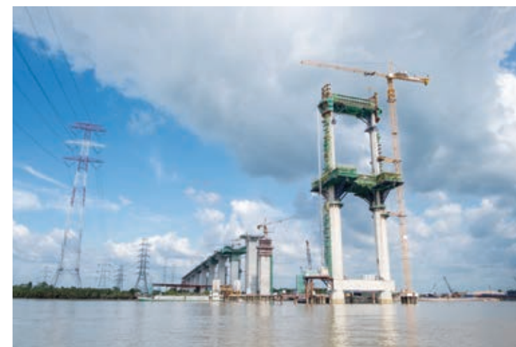
ホーチミン市。建設中の橋
