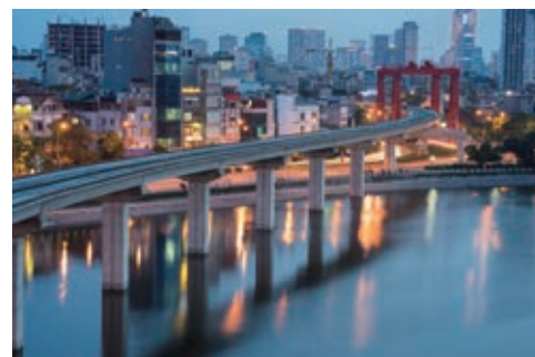
ハノイ市。 ドンダー湖と建設中の橋
