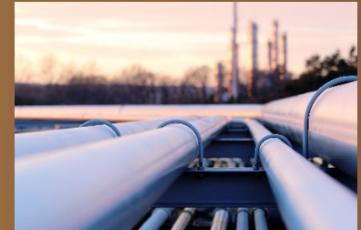
パイプライン
