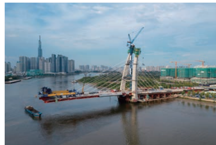
ホーチミン市。建設中の橋
