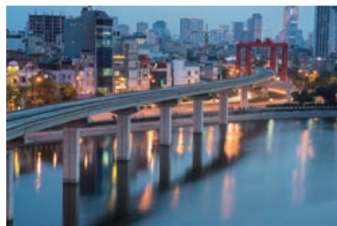
ハノイ市。 ドンダー湖と建設中の橋
